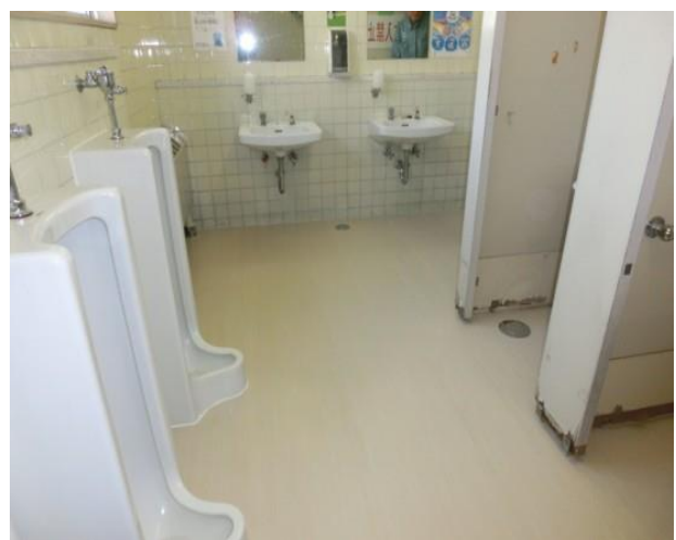
（すまいるの予算：トイレのバリアフリー化工事）
